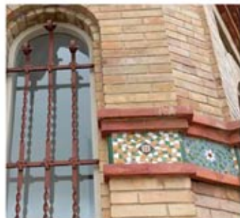
Estació de l'antic tramvia Estación del antiguo tranvía The old tram station Gare de l'ancien tramway Isaac Albènz, 14
