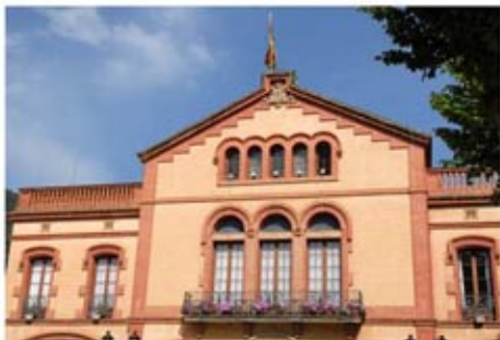
Antic Ajuntament Antiguo ayuntamiento Former Town Hall/Ancienne Mairie Bonaventura Bassegoda Plaça de la Vila, 1
